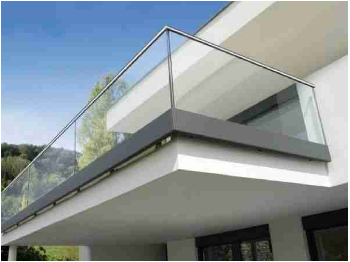
Ban công kính cường lực
