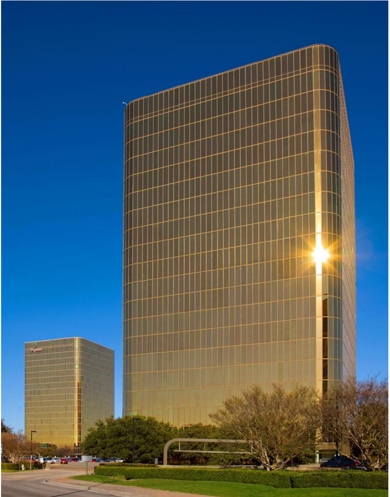
***ESG золотое светоотражающее покрытие стекла для навесных стен***
