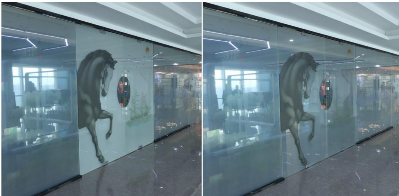
Умное электрическое стекло также известно как умное стекло, переключаемое стекло – это стекло или остекление, свойства светопропускания которого динамически изменяются, чтобы контролировать прохождение солнечного излучения в здания. В общем, стекло изменяется между прозрачным и полупрозрачным и наоборот, либо пропуская свет, либо блокируя некоторые или все длины волн света.
