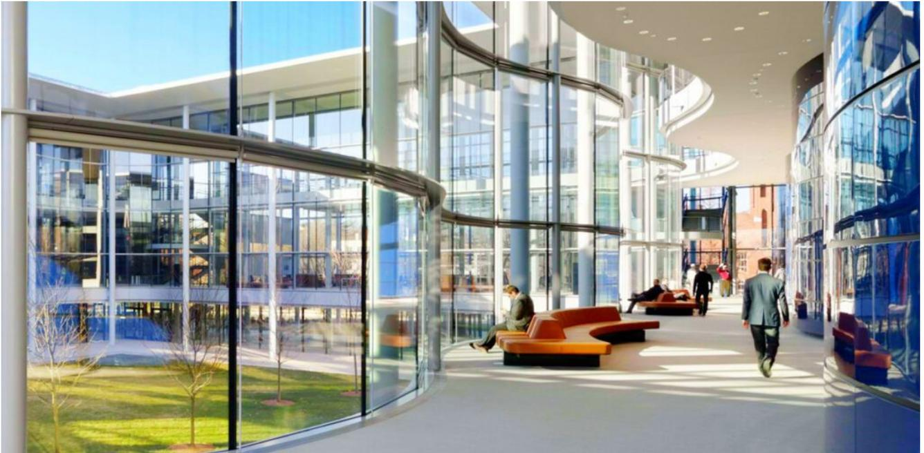
Подобно плоским стеклопакетам, также могут быть изготовлены изогнутые стеклопакеты большого размера. Изоляционная функция достигается тем, что две изогнутые панели с впадиной, заполненной воздухом, собираются с помощью рамы.
