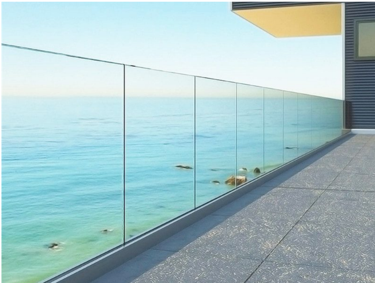
Бескаркасные современные балконные перила
