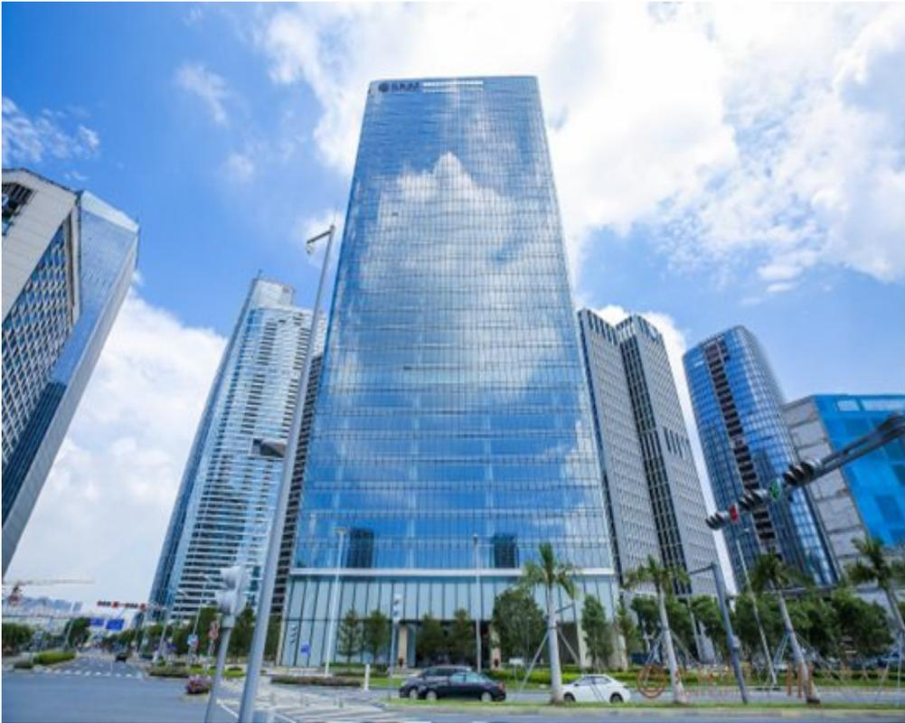
A maneira mais eficaz de maximizar a economia de energia com vidro isolado é através do revestimento Low-E – uma fina película transparente aplicada a uma ou ambas as superfícies da unidade de vidro isolado que reflete a radiação solar para fora durante o tempo quente e para dentro durante o tempo frio. O revestimento low-E também filtra os raios UV nocivos que podem causar desbotamento de móveis, tapetes e outros tecidos.
