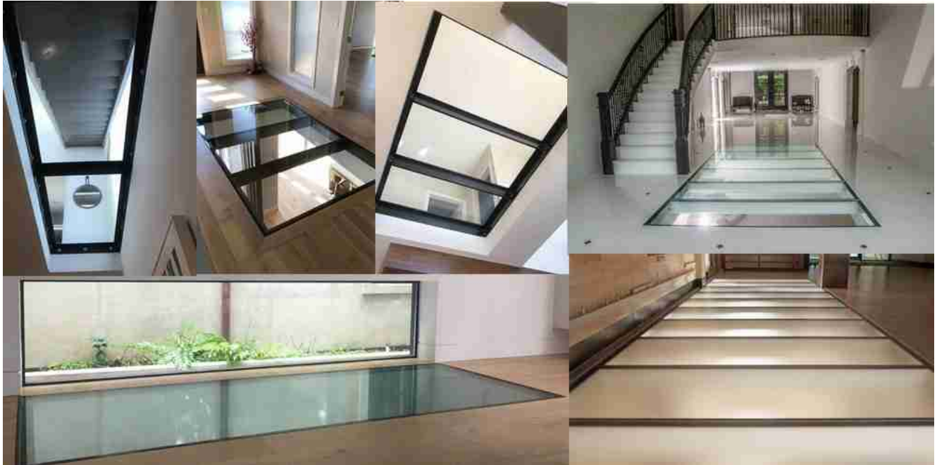
Sistema estrutural de piso de vidro
