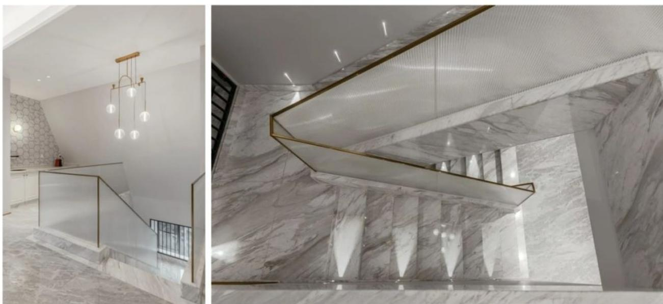
*guarda-corpo em vidro nervurado laminado*
