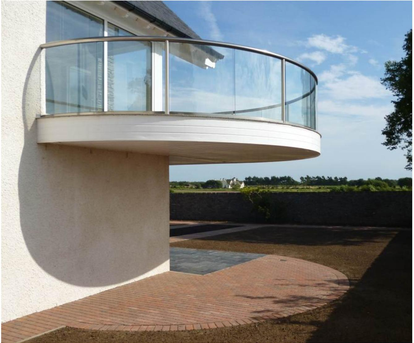
vidro *laminado curvo* para guarda-corpo de *vidro de varanda*
