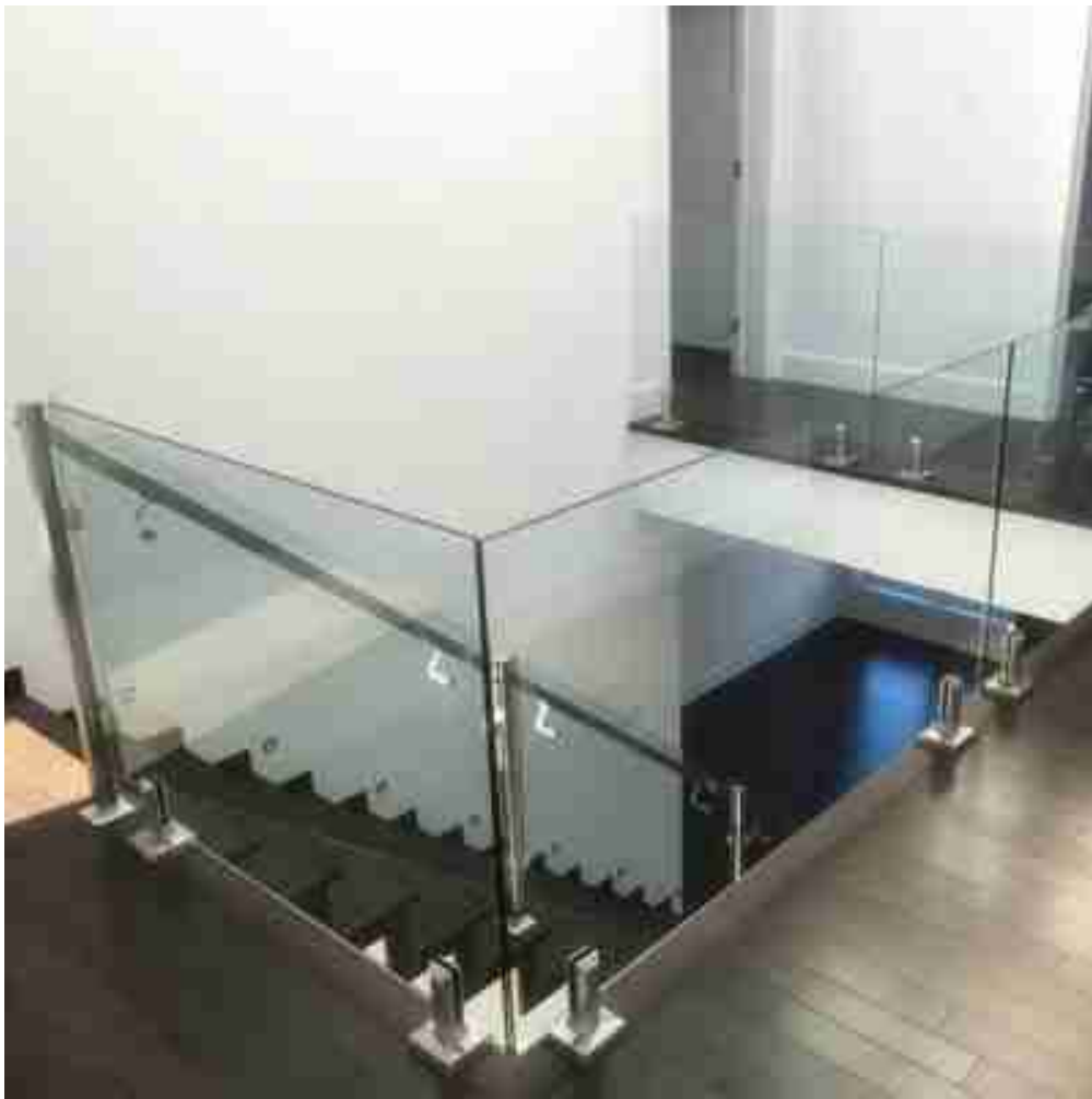
Rampe de spigots pour l'escalier :
