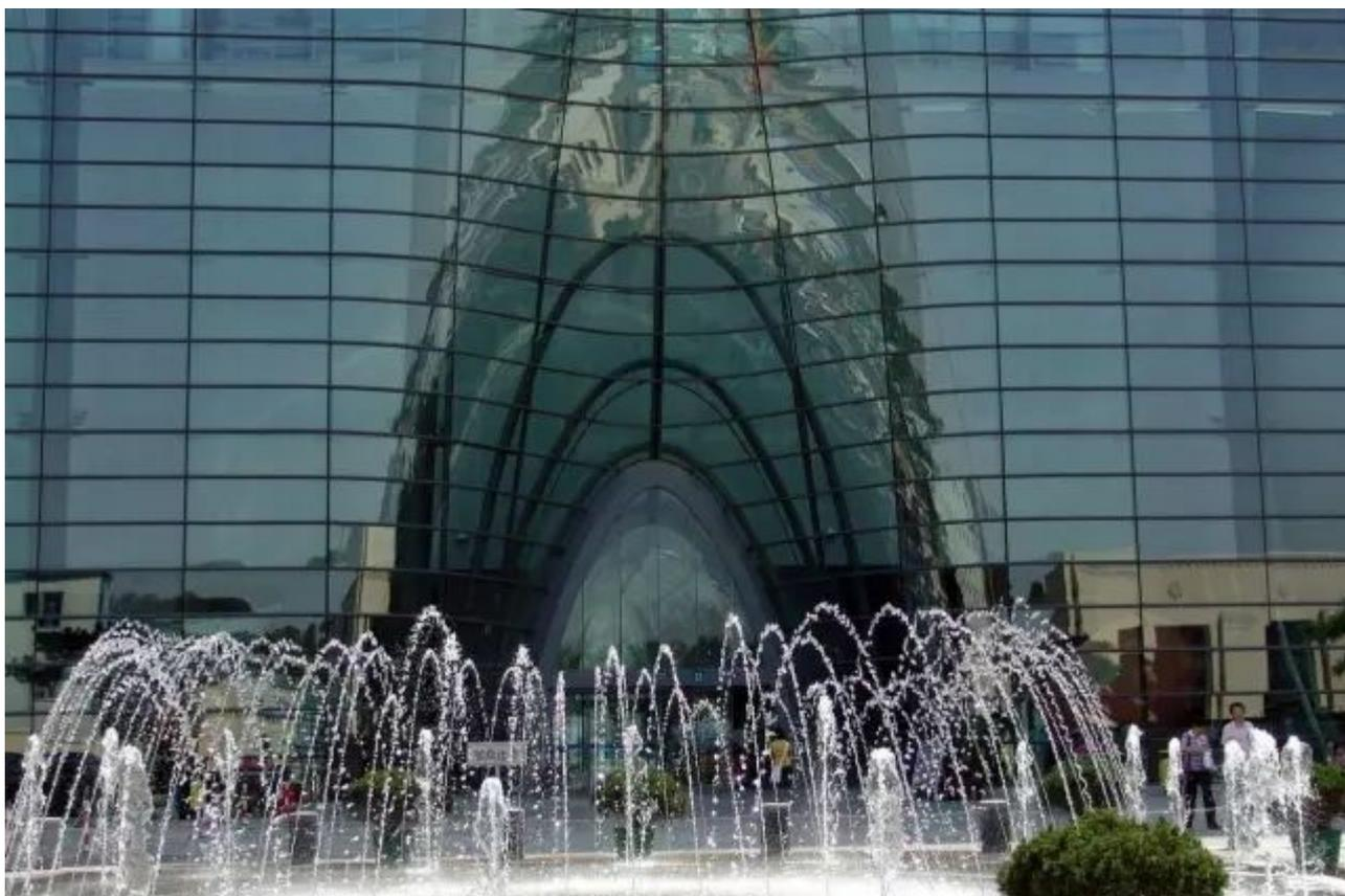
Le verre de sécurité feuilleté est souvent utilisé dans les murs-rideaux et autres applications extérieures, car il aide à résister aux tempêtes de vent, aux tempêtes de grêle et aux vents et impacts de la force d'un ouragan. L'intercalaire à l'intérieur du verre de sécurité feuilleté agit également comme un mur antibruit, ce qui en fait un moyen efficace de réduire le bruit extérieur d'atteindre l'intérieur d'un bâtiment.
