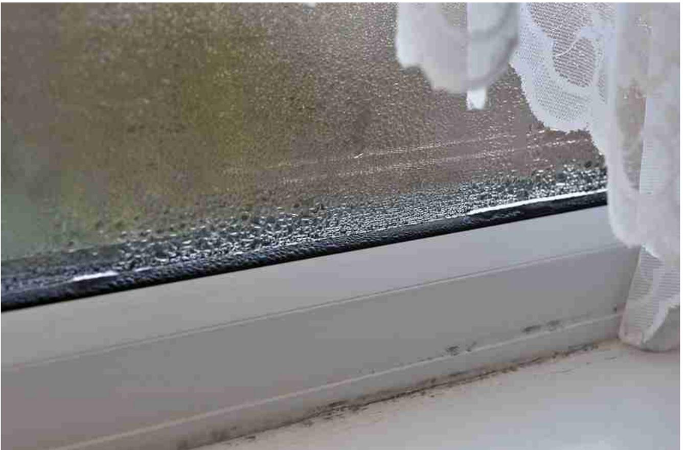
*Condensación en el interior de una ventana de doble acristalamiento sin gas de argón lleno.*
