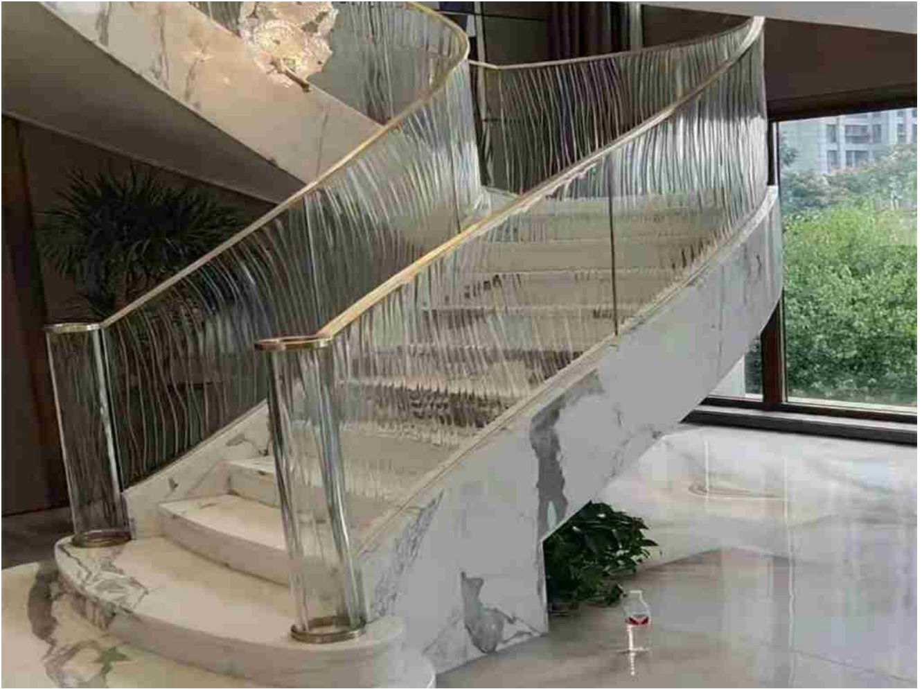
Barandilla de escalera
