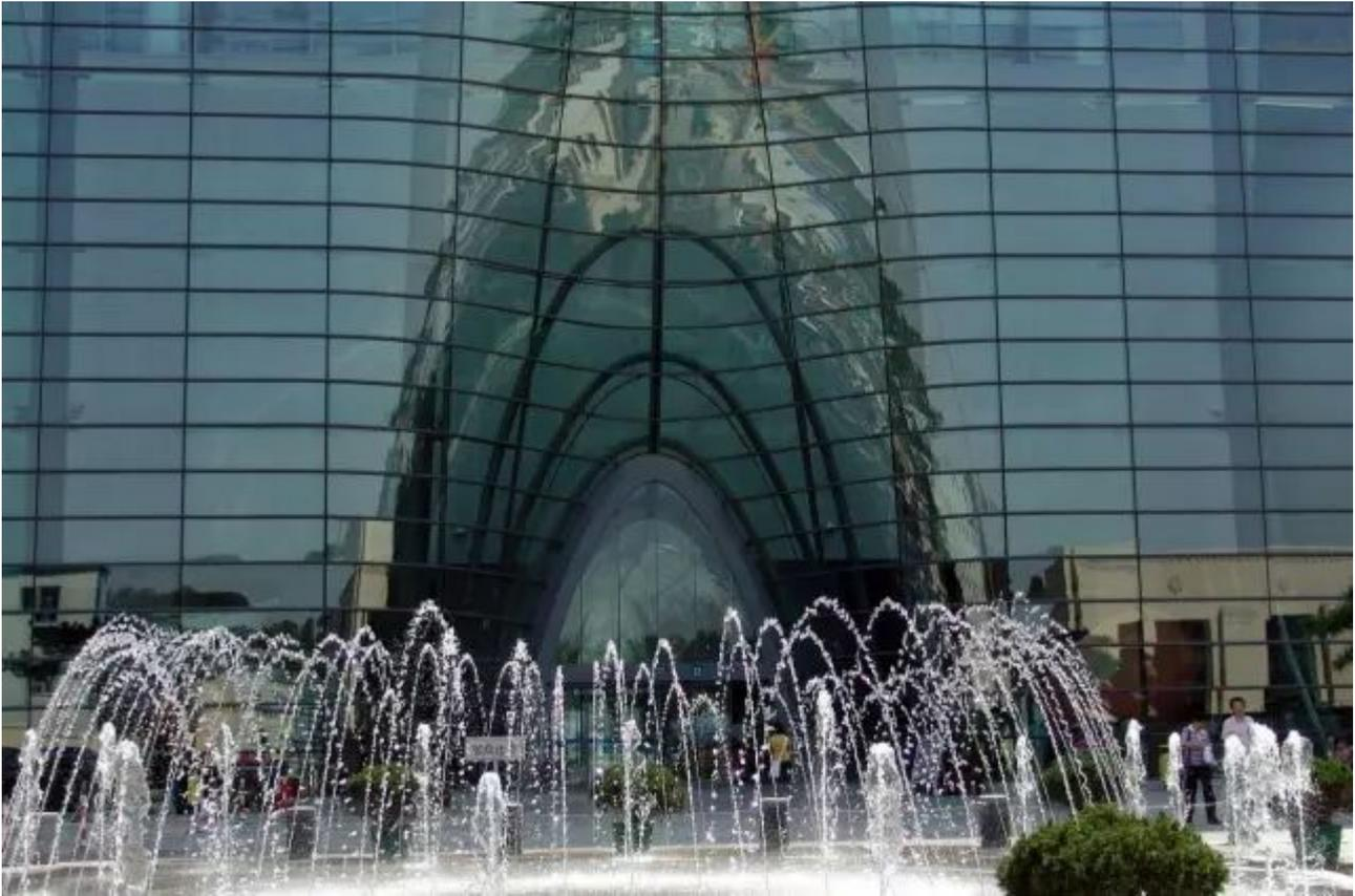
El vidrio laminado de seguridad se usa a menudo en muros cortina y otras aplicaciones exteriores porque ayuda a resistir tormentas de viento, tormentas de granizo y vientos e impactos con fuerza de huracán. La capa intermedia dentro del vidrio laminado de seguridad también actúa como una barrera acústica, por lo que es una forma efectiva de reducir el ruido exterior que llega al interior de un edificio.
