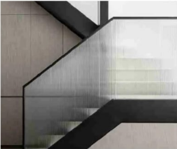
Trabajos de vidrio acanalado de 12 mm
