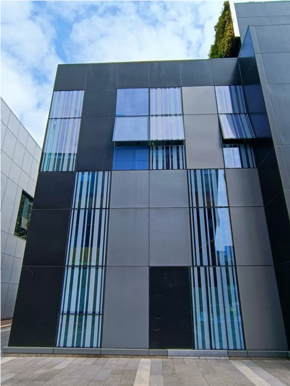
serigrafía con paneles de vidrio con doble aislamiento para fachada
