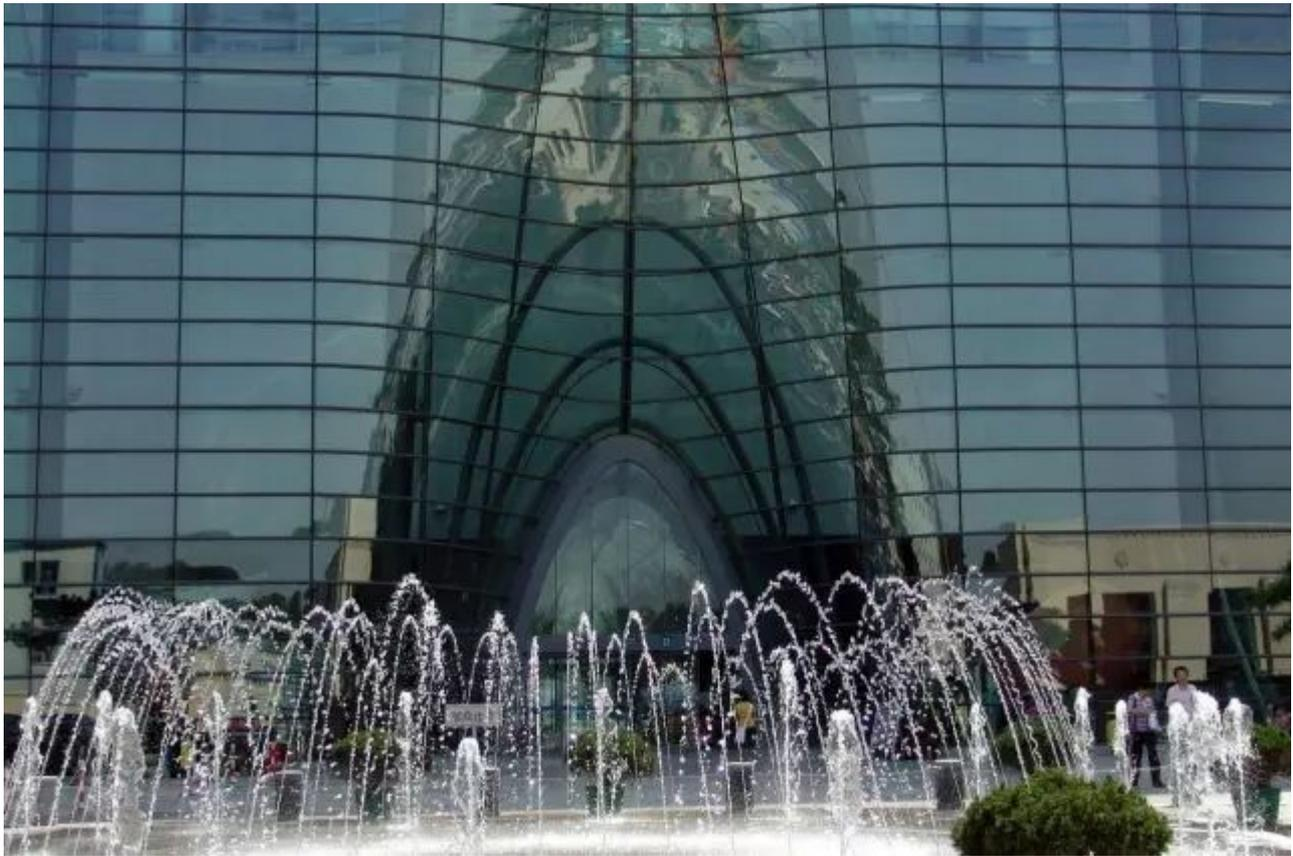
Verbundsicherheitsglas wird häufig in Vorhangfassaden und anderen Außenanwendungen verwendet, da es Windstürmen, Hagelstürmen und Winden und Einschlägen in Hurrikanstärke standhält. Die Zwischenschicht im Verbundsicherheitsglas fungiert auch als Schallschutzwand, wodurch sie eine effektive Möglichkeit darstellt, Außengeräusche zu reduzieren, die in ein Gebäude gelangen.
