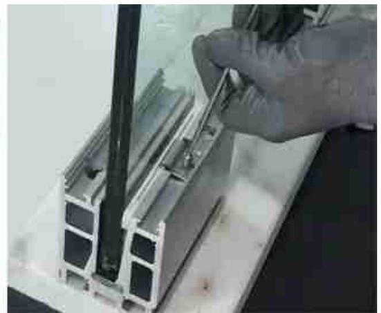
**5. Installieren Sie die Edelstahl-Dichtungsplatte:**
