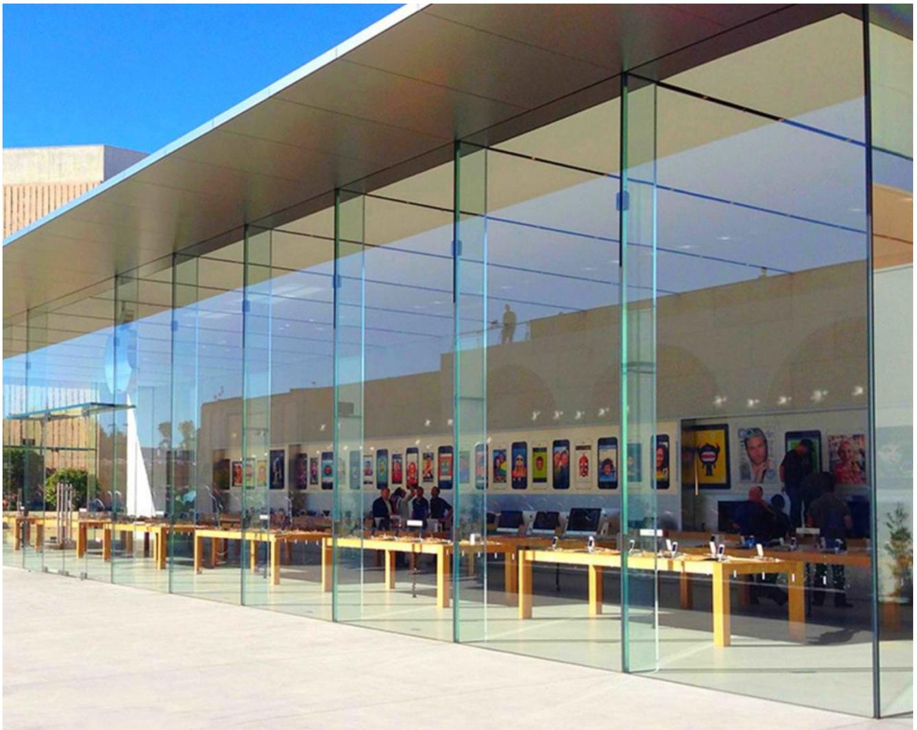
*Verwenden Sie Jumbo-Glas mit geringerem Eisengehalt für optimales Tageslicht*
