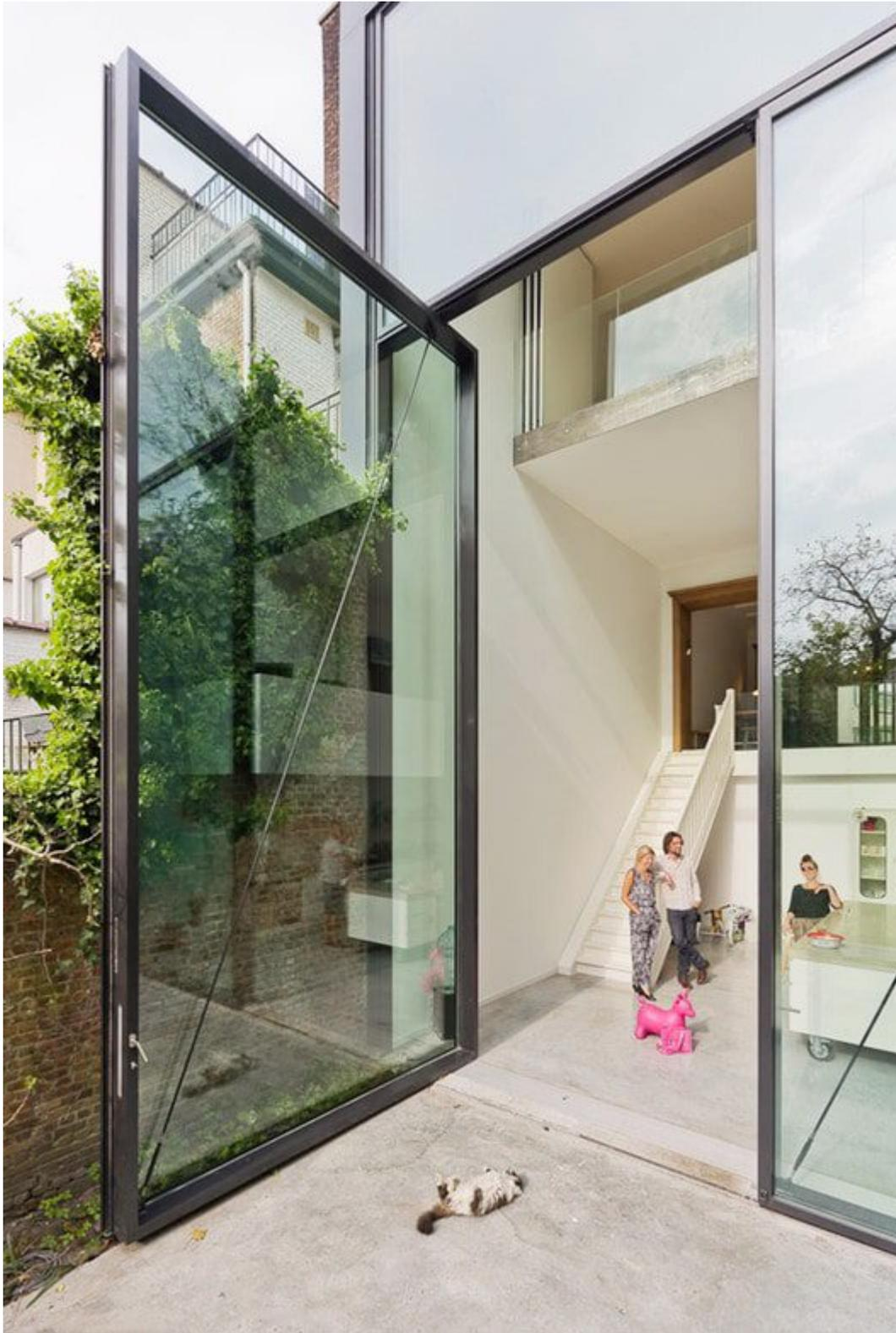
Jumbo-Türen aus gehärtetem Glas bieten doppelte Höhe und doppeltes Licht.
