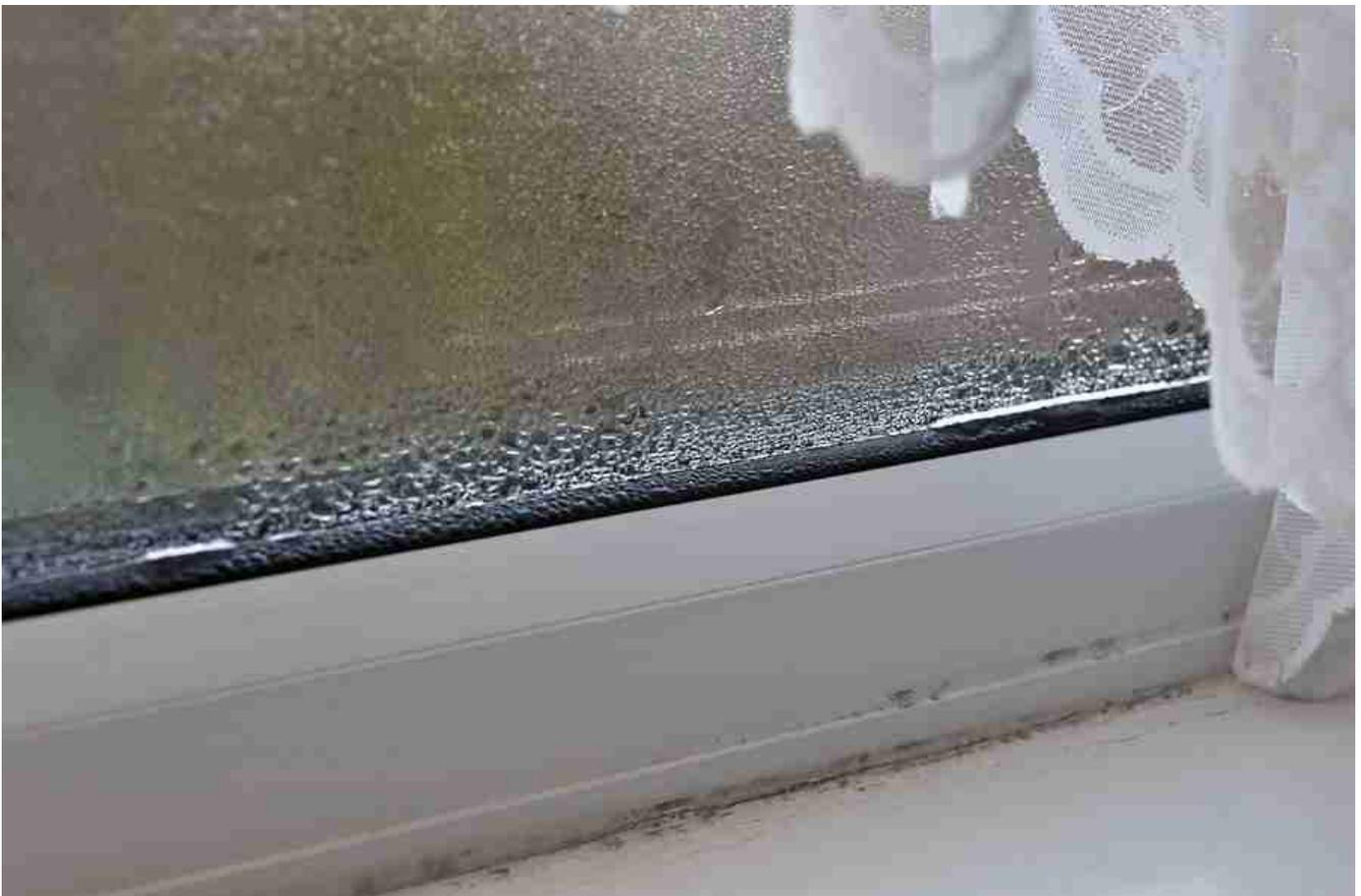
*Kondensation auf der Innenseite eines doppelt verglasten Fensters ohne Argongas gefüllt.*
