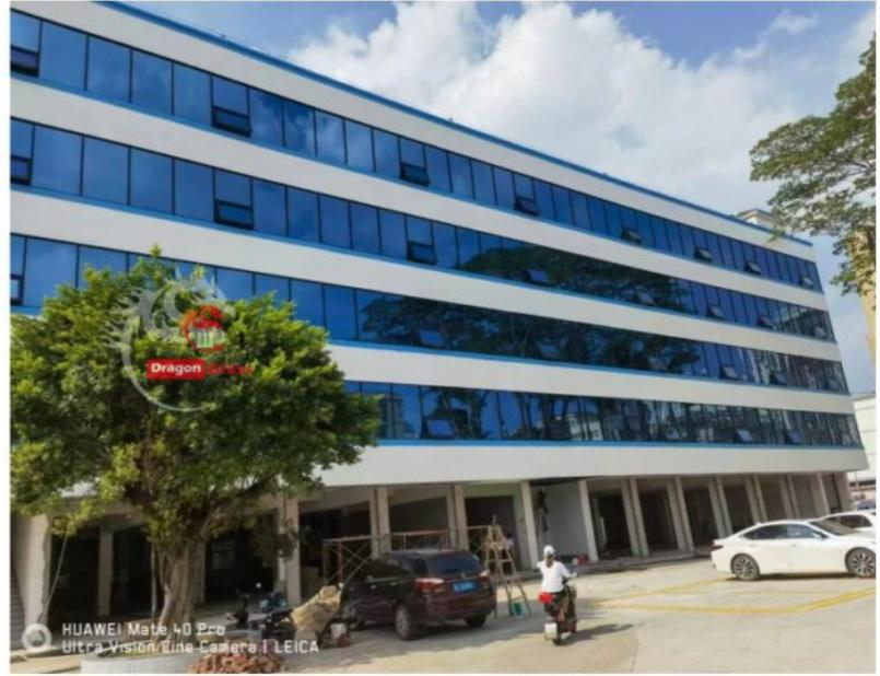
Gehäuse aus Verbundisoliervlas 6mm blau+12A+6,38mm
