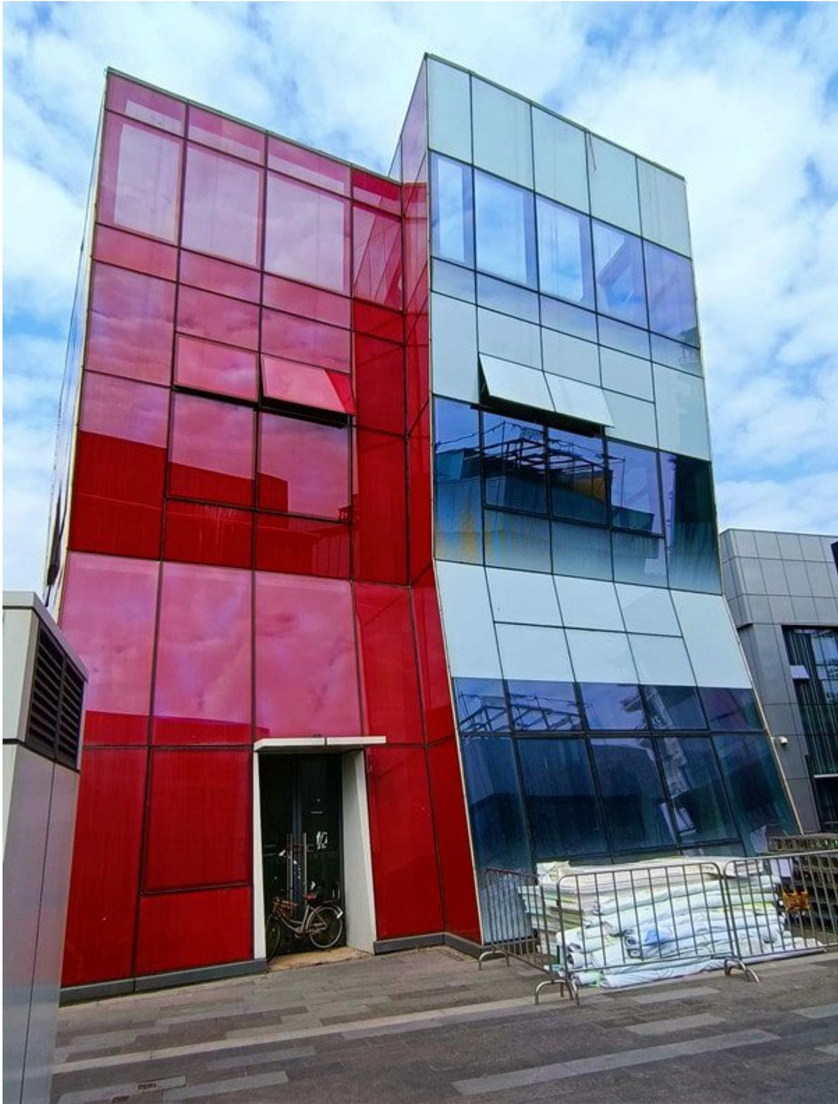
*Siebdruck doppelte Isolierglasscheiben für die Fassade*
