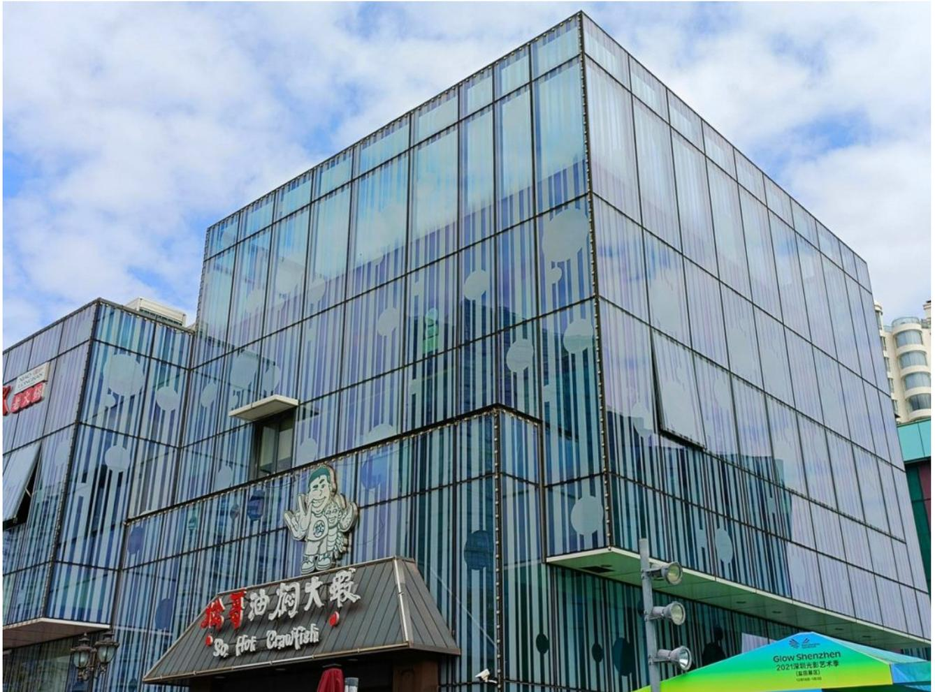
*Siebdruck doppelte Isolierglasscheiben für die Fassade*
