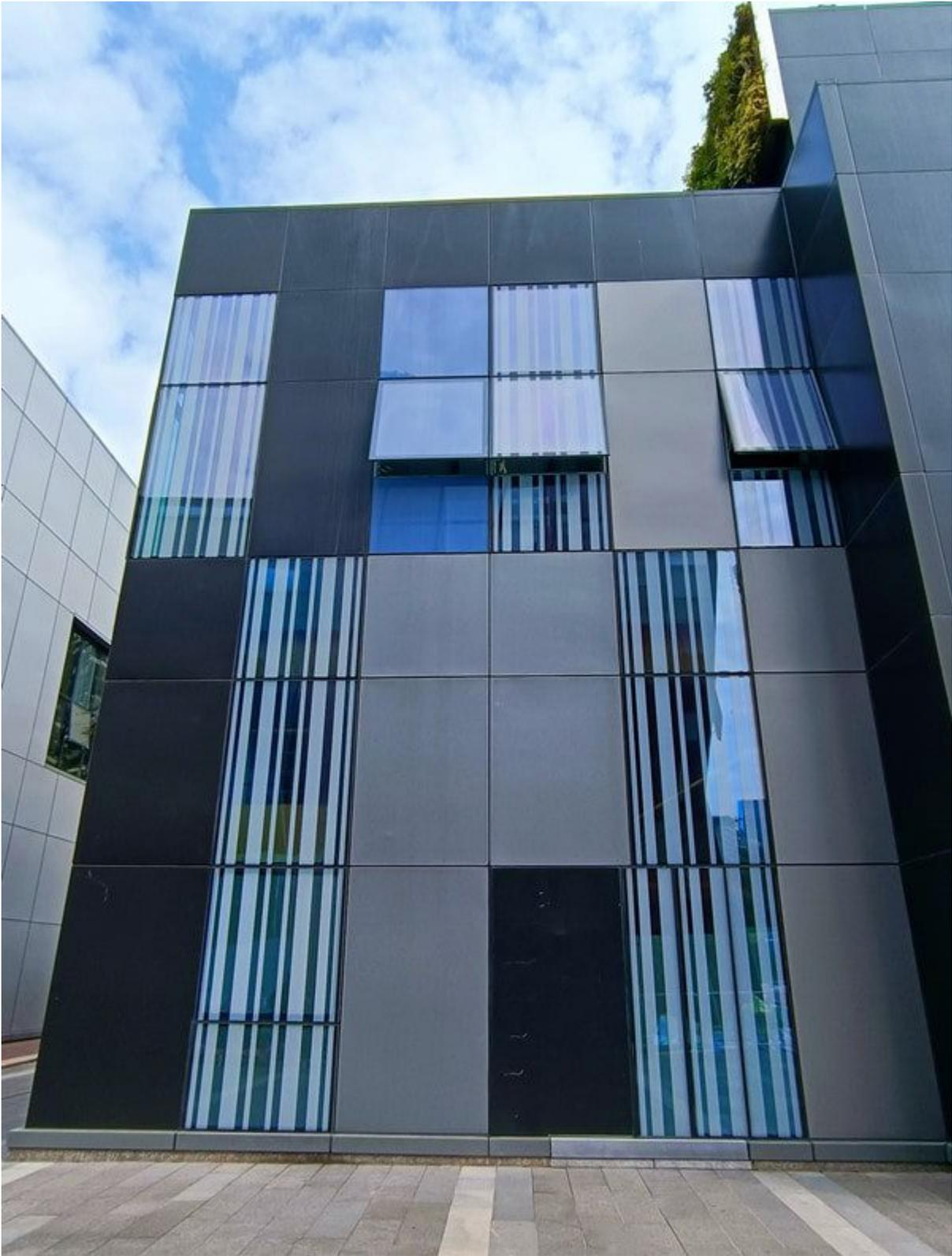
*Siebdruck doppelte Isolierglasscheiben für die Fassade*
