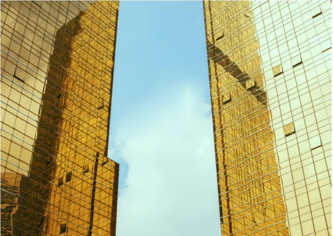
***ESG goldenes reflektierendes Beschichtungsglas für die Fassade***
