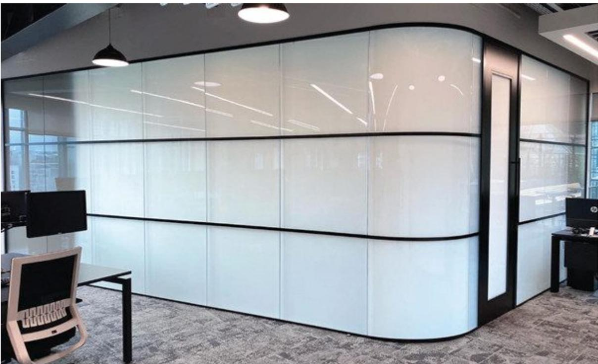
*Smart Glass elektrischer Datenschutzglas Besprechungsraum AUS*
