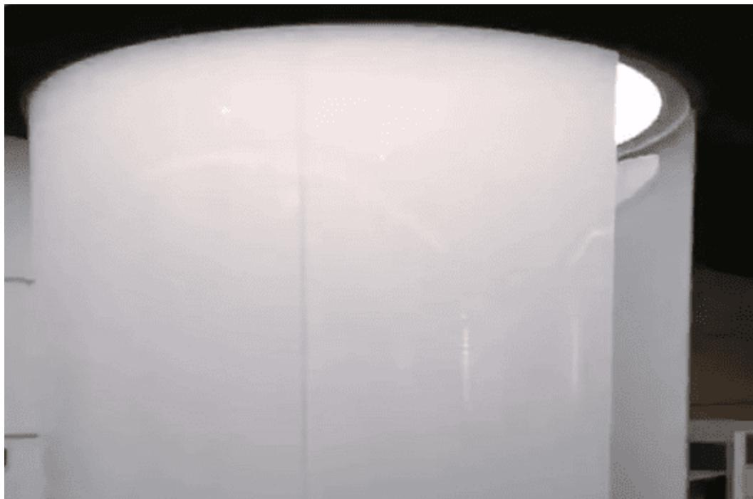
زجاج PDLC هو فيلم رقيق حيث يمكن تثبيته على أي زجاج موجود. يغير مظهره المرئي من متجمد إلى شفاف والعكس بالعكس باستخدام جهاز تحكم عن بعد. لدينا فيلم هو متجمد / مبهم عندما تعمل بالطاقة قبالة وشفافة / واضحة عندما تعمل بالطاقة على. زجاج PDLC متوافق مع أنظمة أتمتة المنزل الذكي. توفر هذه التقنية المذهلة ما يصل إلى 99% من الحماية من الأشعة فوق البنفسجية ورفض الحرارة.
